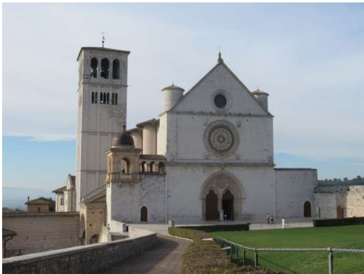
Meget stille novemberdage ved Frans' Basilika.
